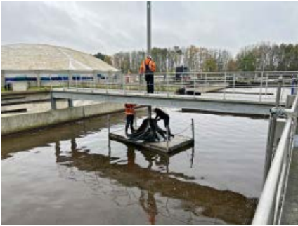
Montage eines Hyperclassic®-Rührwerks Evolution 7 in der Kläranlage Emmen, Niederlande
